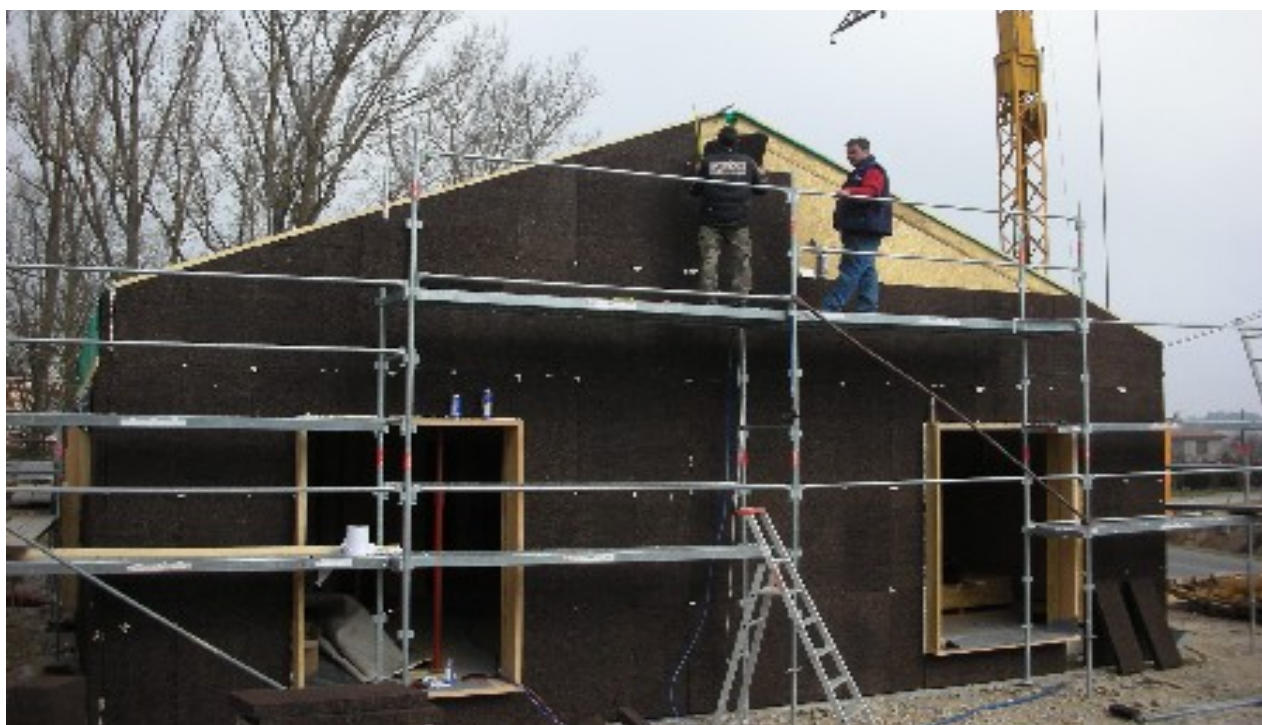
Photo N°5. Les cadres de fenêtres ont été posés sur ce pignon et on a pu, de suite, poser les couches de liège ; ici la pose de la première couche est en cours.
