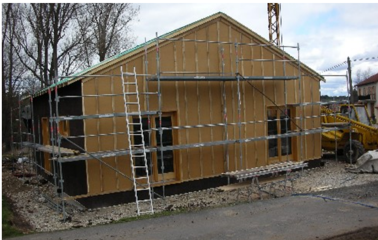
Photo N°6. Les ouvertures en Mélèze 68 mm à vitrage isolant phonique de composition 8/16/44.2 silence- Argon – intercalaire Warm Edwge ont été posées.
