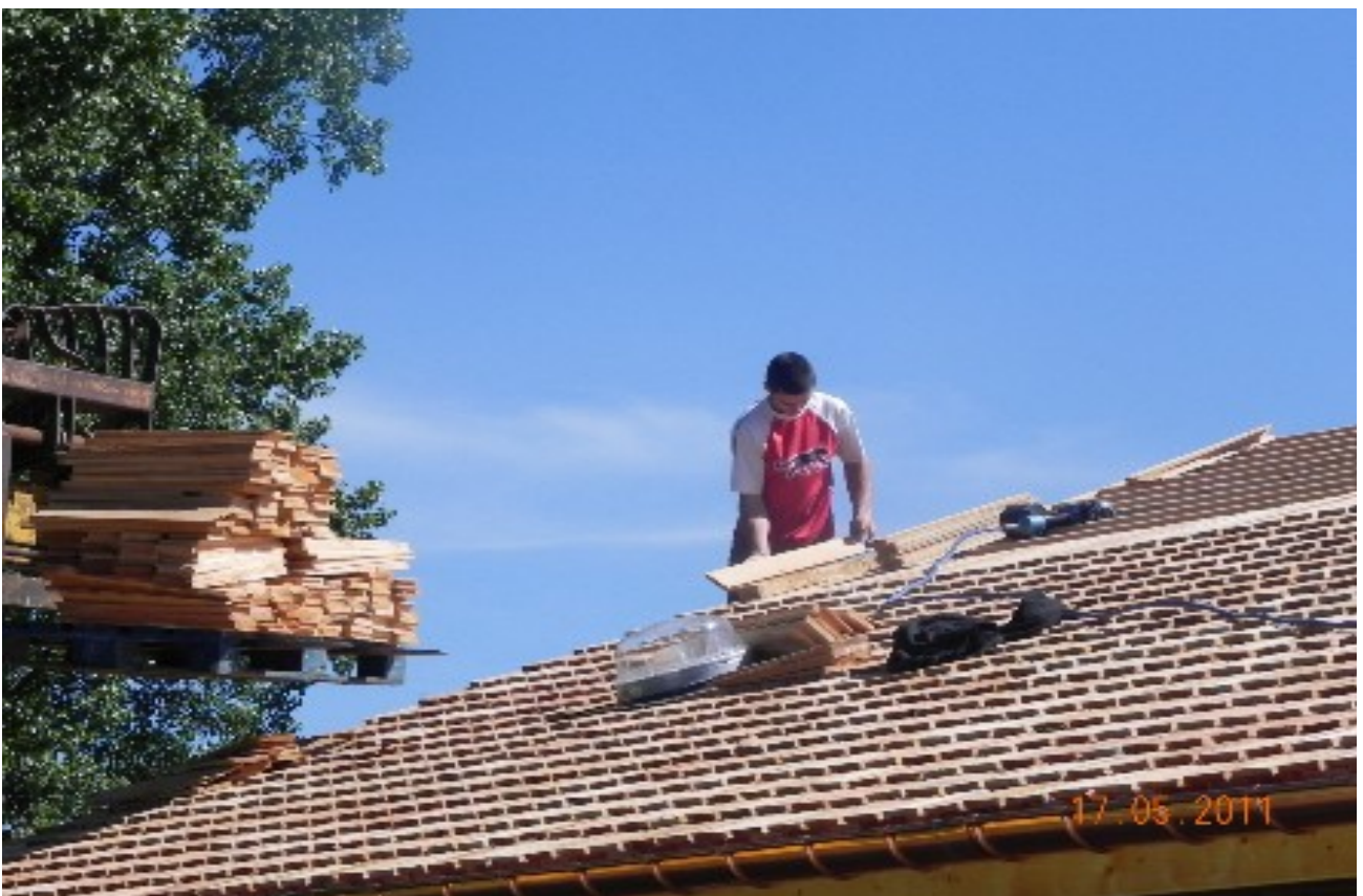
Photo N° 10. Pose des tuiles de bois en Mélèze
