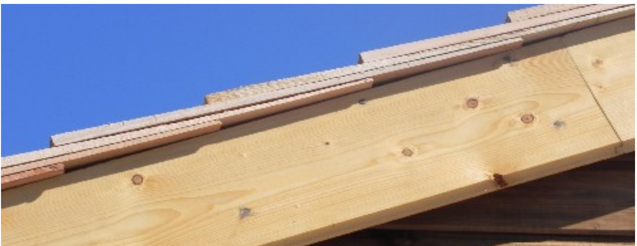
Photo N° 12. Le chevauchement des tuiles, vu en rive.
