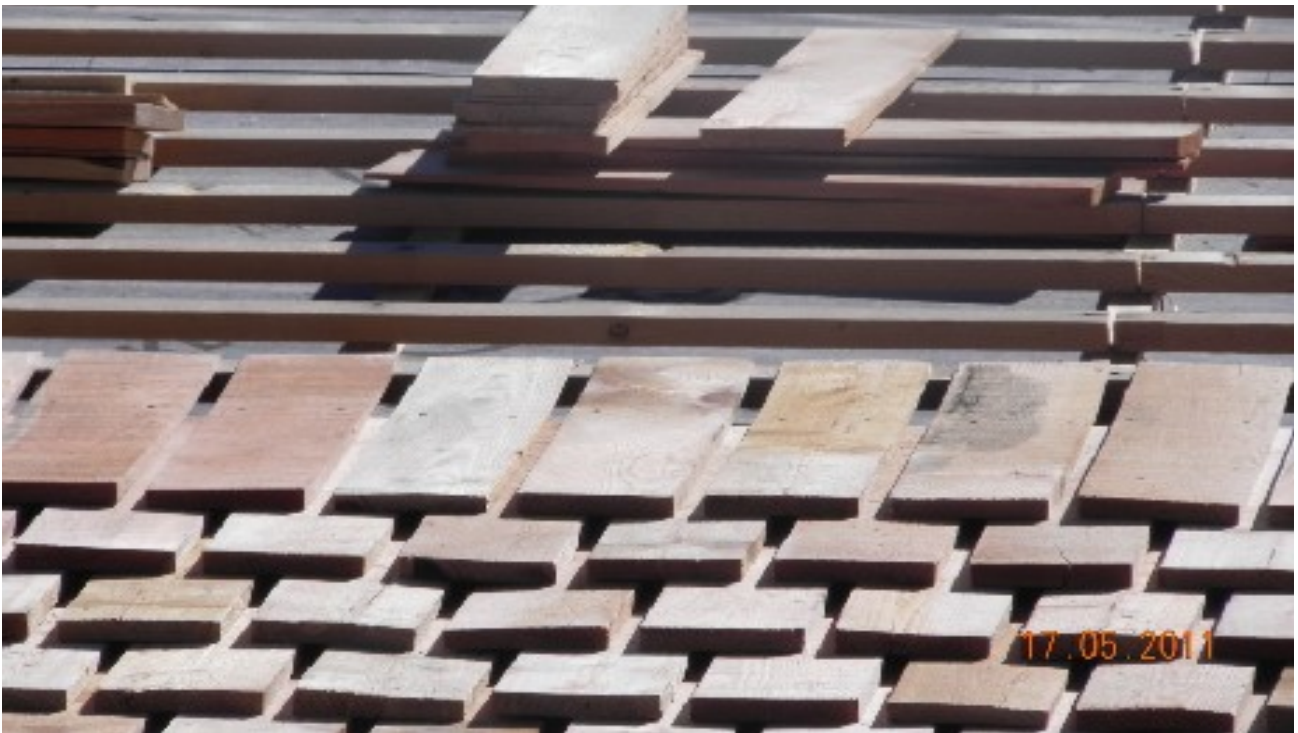
Photo N° 11. Disposition des tuiles de bois sur le double litelage.
