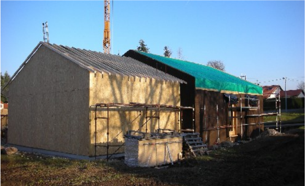
Photo N°7. Vue arrière avec le garage nu en ossature bois et sa charpente classique.
