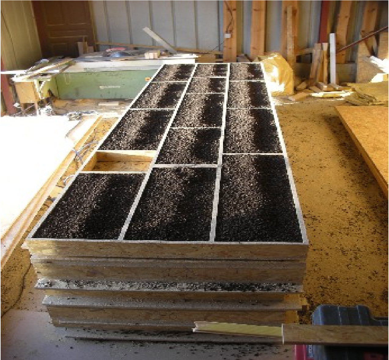
Photo N°1. Dans l'atelier de fabrication, voici un coffre de plancher qui vient d'être rempli de granules de liège.
