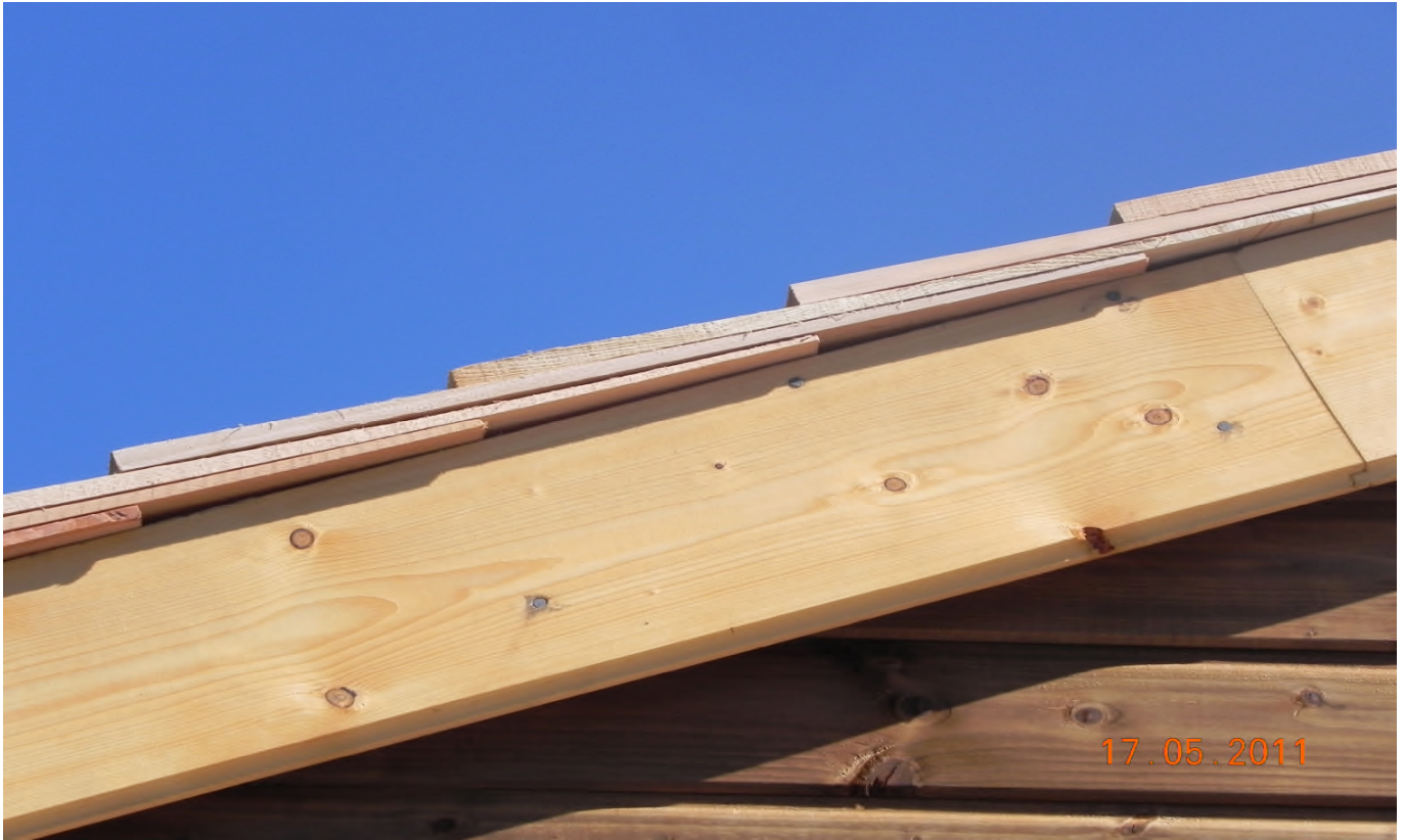
Le chevauchement des tuiles, vu en rive.
