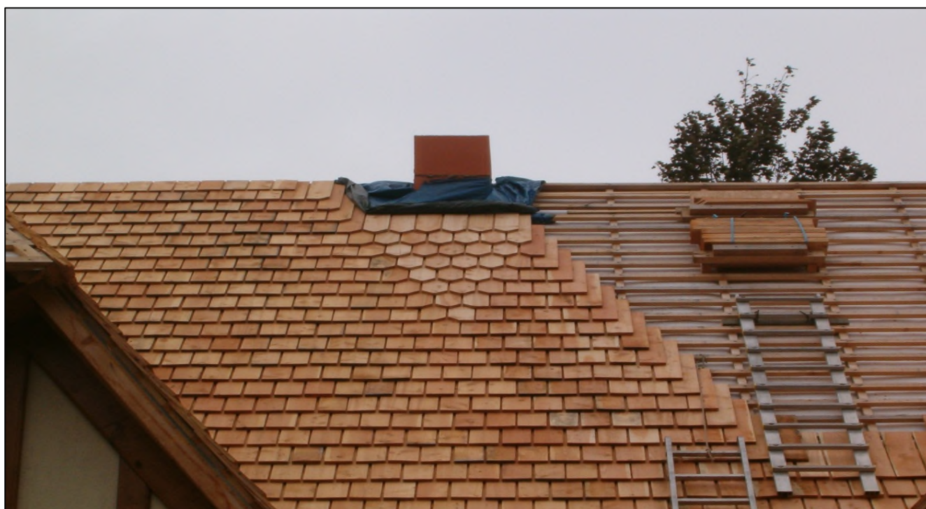
Travaux de couverture en Bois.
