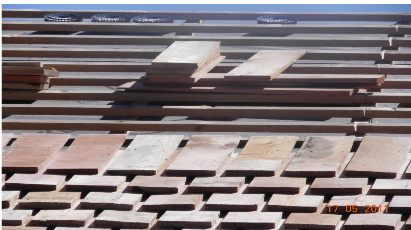
Disposition des tuiles de bois (litage croisé).
