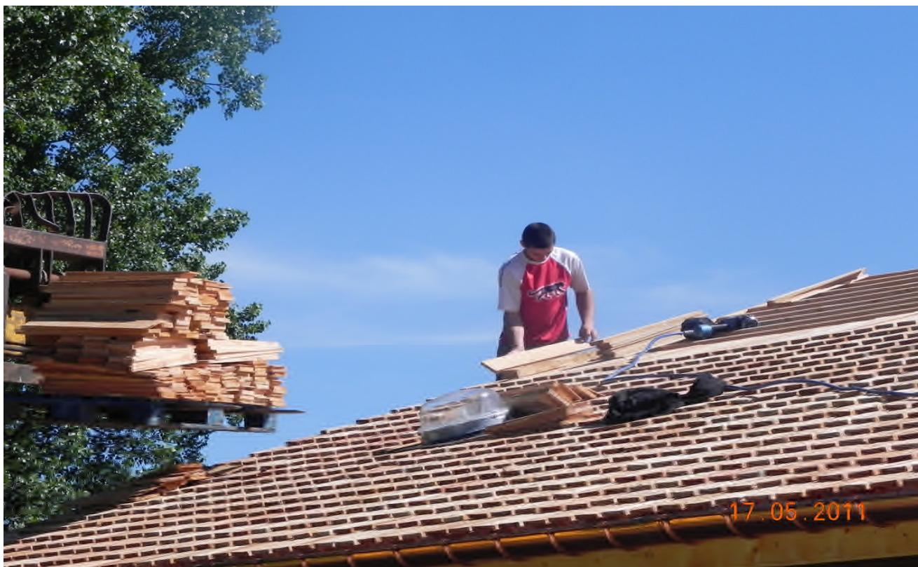
Pose de tuiles de bois en Mélèze.
